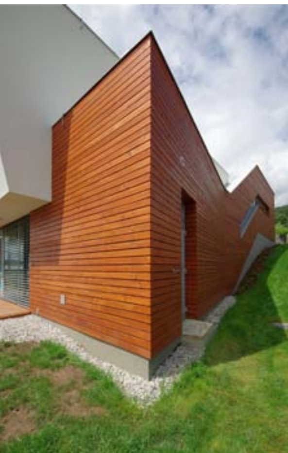
Sestup z horního podlaží do spodní společenské zóny umožňuje přímé schodišťové rameno s dřevěným obkladem, které kopíruje svažité terén a doslova se po něm „plazí“
